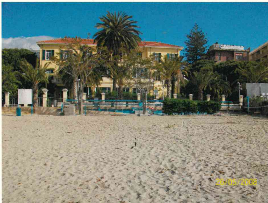
PROSPETTO SUD -VISTA GENERALE
